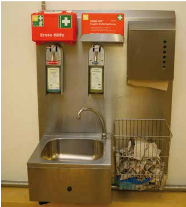
Hygieneschleuse mit Handwaschbecken inkl. Einweghandtücher und Reinigungs- und Desinfektionsmittel, Quelle: Mayringer, LK ÖÖ
